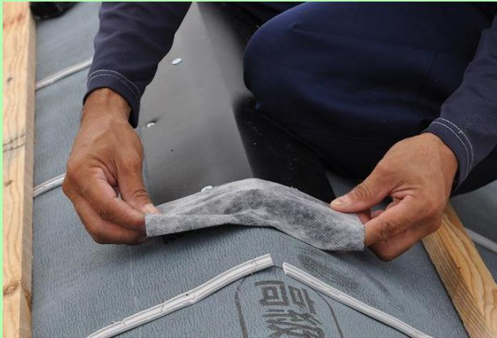
換気棟の両端を防水テープでシールします。
