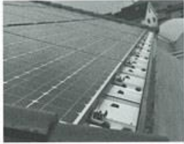
太陽発電パネルを設置する部分に透湿ルーフィングを敷設(左)。その上にあらかじめ取り付け金具を設置した鋼板の波板を並べる(中)。太陽発電パネルを固定し、水切りなどで周辺を見切る(左)
