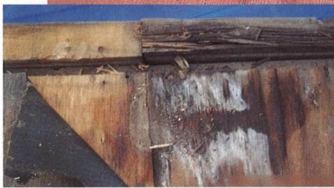
上は化粧スレートを剥がした様子。化粧スレートの重なり部分がぬれている。また、ケラバからの雨水がオーバーフローして化粧スレートの表面に流れていた。左はアスファルトルーフィングを剥がして野地合板を見たところ。野地合板もぬれていた (写真：屋根システム総合研究所)
