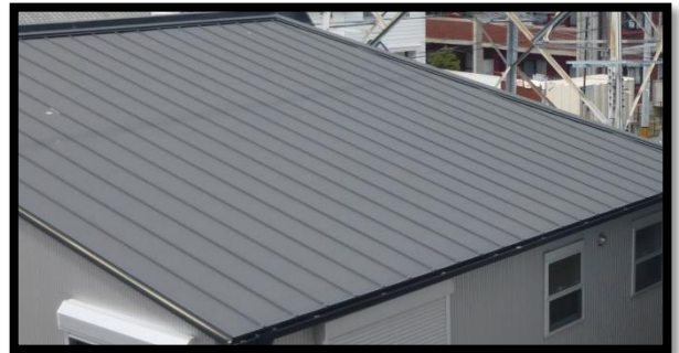
金属屋根：ロフト 6°C↑ 高温化
