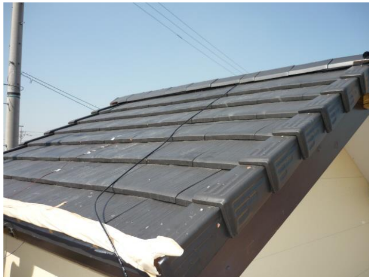
図.8 瓦施工状態
